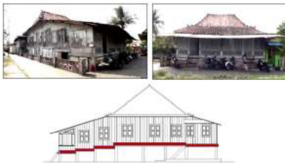
Gambar 1. Rumah Limas Palembang yang masih teridentifikasi (milik Bapak Marsel 32 Ilir, Palembang) berlantai panggung dengan jumlah tingkatan hingga 4 level [6]
