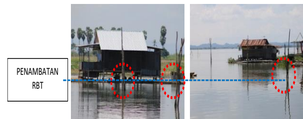
Gambar 7. Penambatan RBT berupa tonggak kayu jati yang dipancang ke dasar danau (Sumber : Hasil survey Danau Tempe, 2014)
