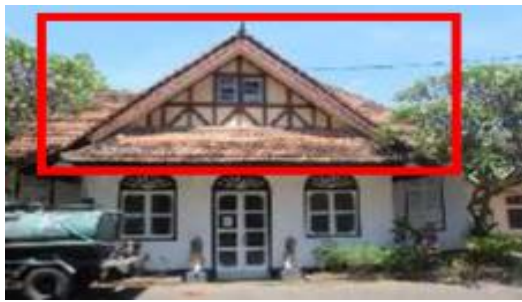
Gambar 5. Penampilan bangunan Gereja GPIB Pniel yang sangat khas dengan menara dan lubang ventilasi untuk pencahayaan dan sirkulasi udara
