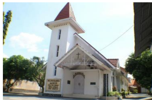
Gambar 4. Penggunaan gevel pada bagian atap pelana dengan sudut kemiringan 30°.
