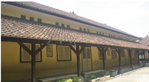
Gambar 2. Bentuk dan ukuran jendela yang lebar dan tinggi dengan dua daun pada bangunan Kantor Dinas Perumahan, Permukiman, dan Pertanahan Kabupaten Buleleng
