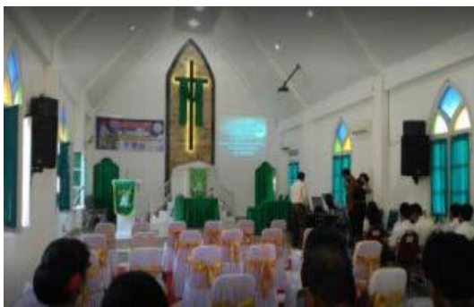
Gambar 6. Kondisi ruang dalam gereja yang tanpa ditutupi oleh plafond dan mengikuti bentuk atap pelana.
