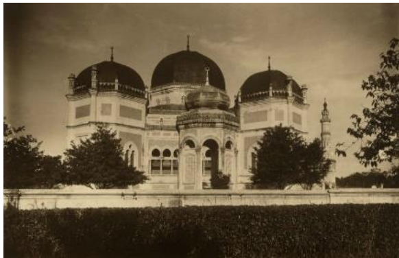
Gambar 10. Pagar tembok pada awal pembangunan (Sumber: KITLV, diakses tahun 2017)
