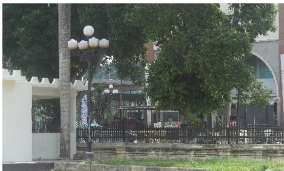
Gambar 11. Besi yang ditambahkan diatas pagar tembok (Sumber: Dokumentasi Pribadi, 2017)
