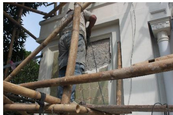
Gambar 19. Proses pengerokan ubin pada eksterior menara masjid (Sumber: Dokumentasi Pribadi, 2017)
