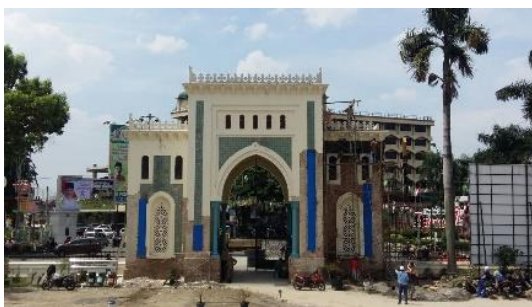
Gambar 21. Proses pengecatan ulang bangunan pagar masjid (Sumber: Dokumentasi Pribadi, 2017)
