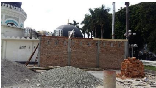
Gambar 22. Proses pembangunan bangunan gudang (Sumber: Dokumentasi Pribadi, 2017)
