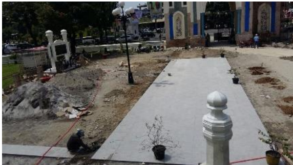
Gambar 20. Proses penggantian keramik pada pekarangan masjid, (Sumber : Dokumentasi Pribadi, 2017)
