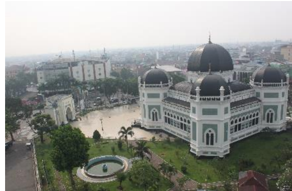
Gambar 3. Foto kompleks Masjid Raya Al-Mashun yang diambil dari bagian atas menara memperlihatkan halaman masjid raya bagian depan yang sudah ditutupi dengan keramik dan terdapat penambahan kolam dan perkerasan untuk akses dari bagian depan masjid menuju kolam dan area pekuburan, (Sumber: Dokumentasi Pribadi, 2017)
