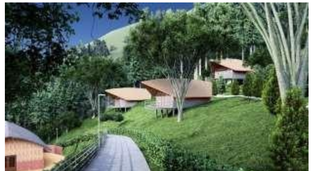
Gambar 9 Bangunan panggung meminimalkan cut and fill
