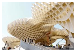
Gambar 8. pengelolaan bentuk alam berupa kontur dan karakter tumbuhan diterapkan pada sistem struktur sebagai elemen arsitektur pada bangunan Metropol Parasol di Seville, Spain. Sumber: www.designboom.com
