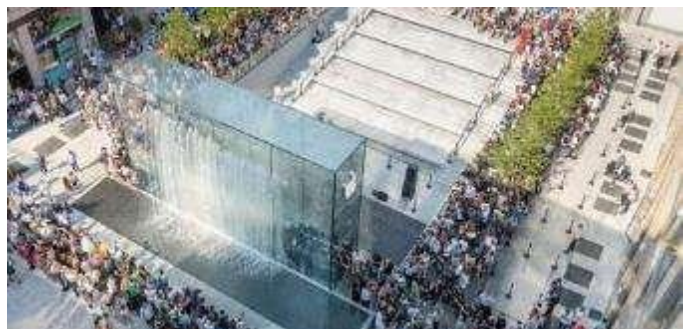
Gambar 14. Pengolahan lanskap dengan fitur air sebagai akses dan potensi pemandangan pada bangunan retail Pizza Liberty milik Apple di Itali
