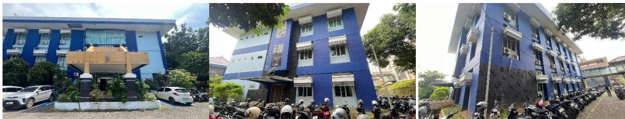
Gambar 2. Kondisi Eksisting Fasad Gedung B FPIK UNDIP
