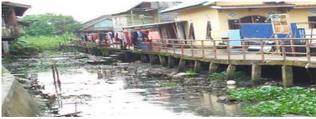
Gambar 9. Model struktur tiang penyangga dengan material permanen
