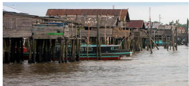
Gambar 8. Model struktur tiang penyangga rumah panggung
