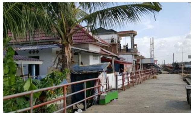
Gambar 1. Permukiman dan Rumah baru di tepi Sungai Musi Kelurahan 3-4 Ulu yang berada di bawah jalan dan tidak bertiang.
