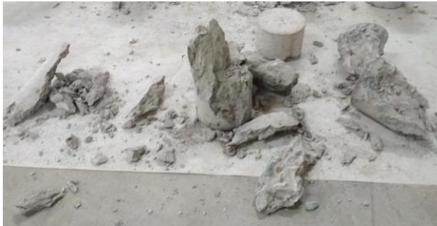
Gambar 10. Kondisi benda uji yang mengalami segregasi
