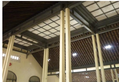
Gambar 9. Konstruksi pertemuan saka guru dengan balandar dan pangeret
