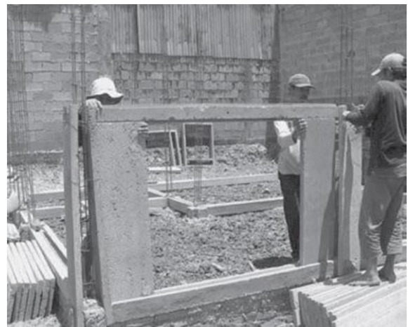
Gambar 5. Proses perakitan panel beton bertulang bambu prefabrikasi (sumber: Widyowijatnoko, 2008)
