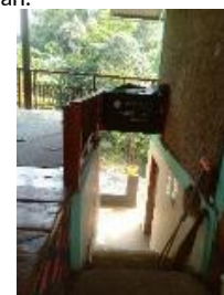
Akses tangga ke lantai bawah di antara bangunan 1 dan bangunan
