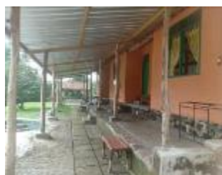
Teras dan Kanopi Bangunan 1.
