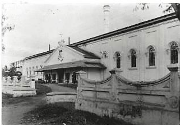
Gambar 8. Fasad bangunan Pabrik Gula Kreet dokumentasi tahun 1920 [22].
