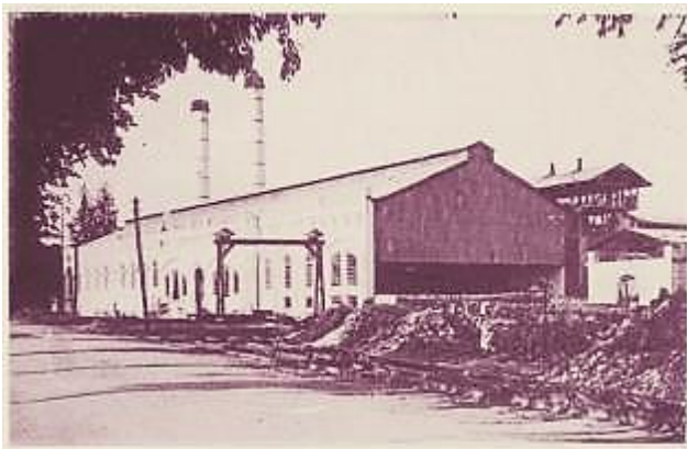
Gambar 7. Fasad bangunan Pabrik Gula Redjo Agoeng dokumentasi tahun 1930 [21].
