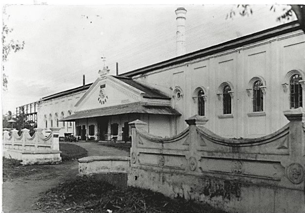
Gambar 8. Fasad bangunan Pabrik Gula Kreet dokumentasi tahun 1920 [22].
