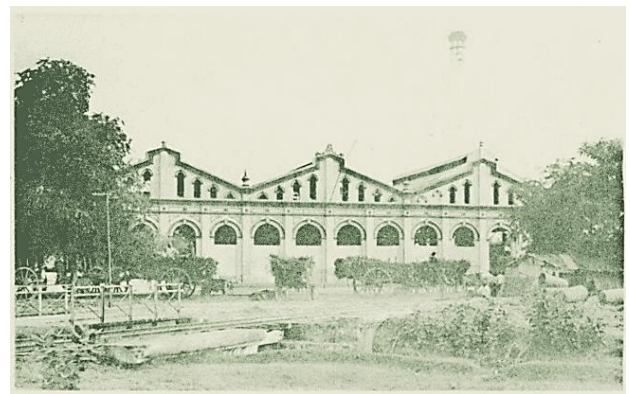
Gambar 6. Fasad bangunan Pabrik Gula Djatiroto dokumentasi tahun 1930 [20].
