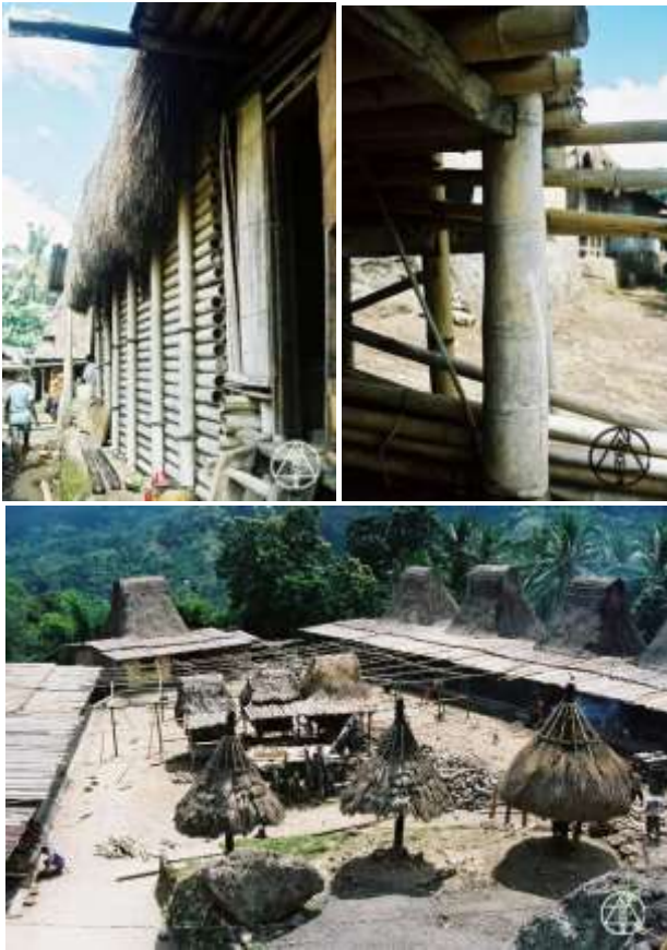
Gambar 1. Pemanfaatan bambu sebagai atap pelataran, penutup dinding, kolom dan balok lantai di Kampung Nage, Flores [12]
