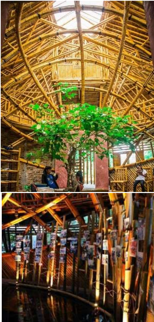
Gambar 3. Penggunaan bambu sebagai bahan utama konstruksi bangunan pada Green School, Bali [19]
