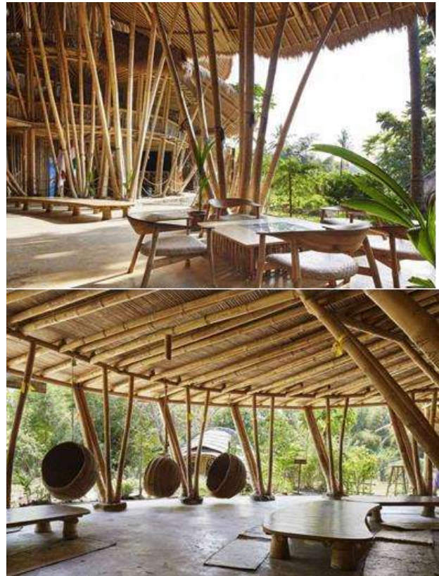
Gambar 4. Penggunaan material bambu pada struktur atap bangunan di dodoha mosintuwu , Tentena, Poso, Sulawesi Tengah [20],[21]
