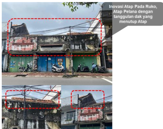
Gambar 9. Atap Pada Bangunan Ruko Sumber: Survey Lapangan, 2024
