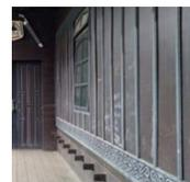
Sama seperti rumah adat yang ada di desa kampung baru, dinding masih menggunakan papan dengan 2 penyusunan dinding yaitu secara vertikal dan horizontal. Pada rumah *indung* bagian dinding disusun secara vertikal sedangkan pada bagian rumah yang lain, dinding disusun secara horizontal. Perbedaan kedua susunan dinding ini
